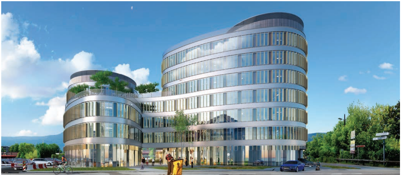
Perspective du bâtiment Linklab et panorama du chantier Linklab
