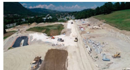
Aménagement du parc d'activités Les Sources
