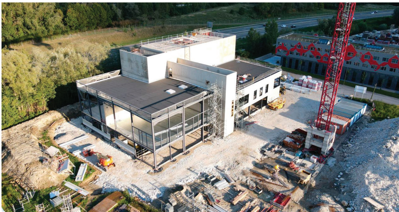
Batiment Windsalps en construction
