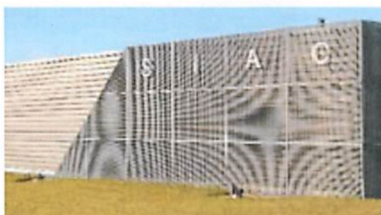
► Traitement de façade mettant en valeur un dispositif d'enseigne sobre et élégant (Lettres découpées en métal) Atelier de cablage à Andrezé (49) P. Bossard architecte.
