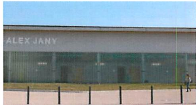
► Enseigne en lettres découpées appliquée sur une maçonnerie enduite - Complexe Alex Jany à Toulouse (31)- Architectes MBa
