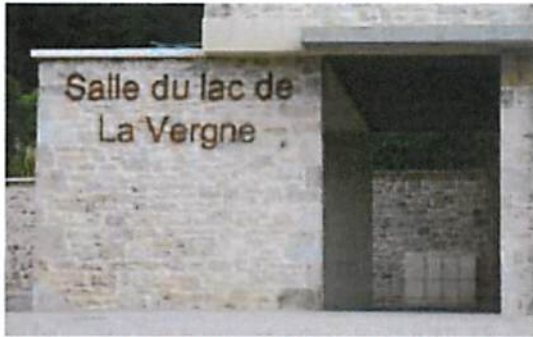
► Une enseigne en lettres découpées s'installe sur un volume dont le décrochement marque l'entrée du bâtiment - Caillac (46) P. Bosc architecte
